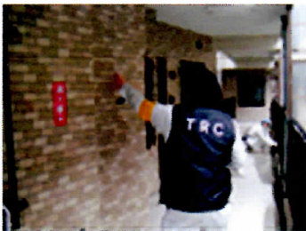
(壁の打診診断)
